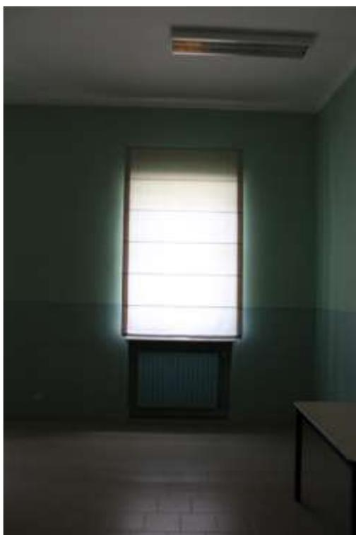
Foto 4\_ Interno, aule, serramenti e sottofinestra con alloggiato terminale del sistema di riscaldamento
