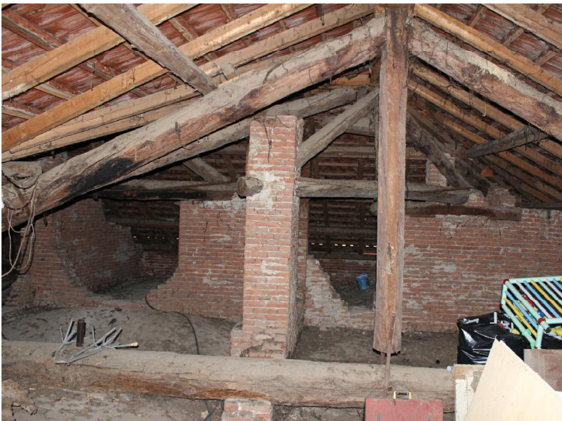
Foto 10_Sottotetto, privo di coibentazione
