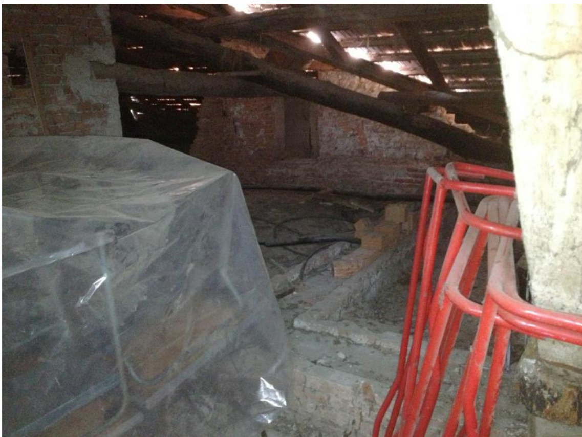
Foto 6_Sottotetto, privo di coibentazione
