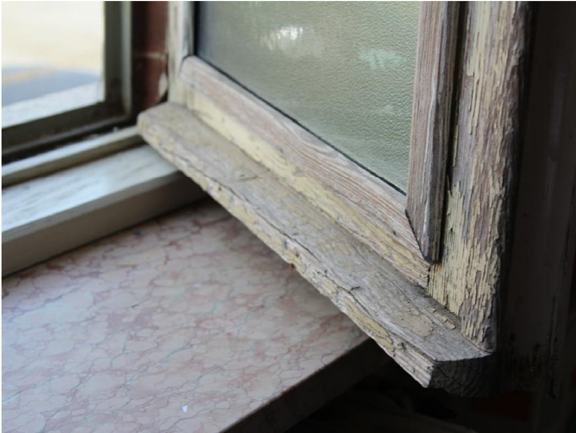
Foto 9_Particolare serramento in legno
