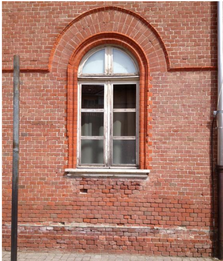
Foto 3_Particolare degli infissi e della struttura muraria
