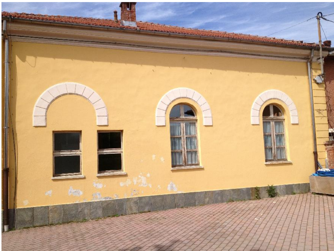
Foto 4_Particolare della manica Ovest (serramenti lignei vetro singolo)
