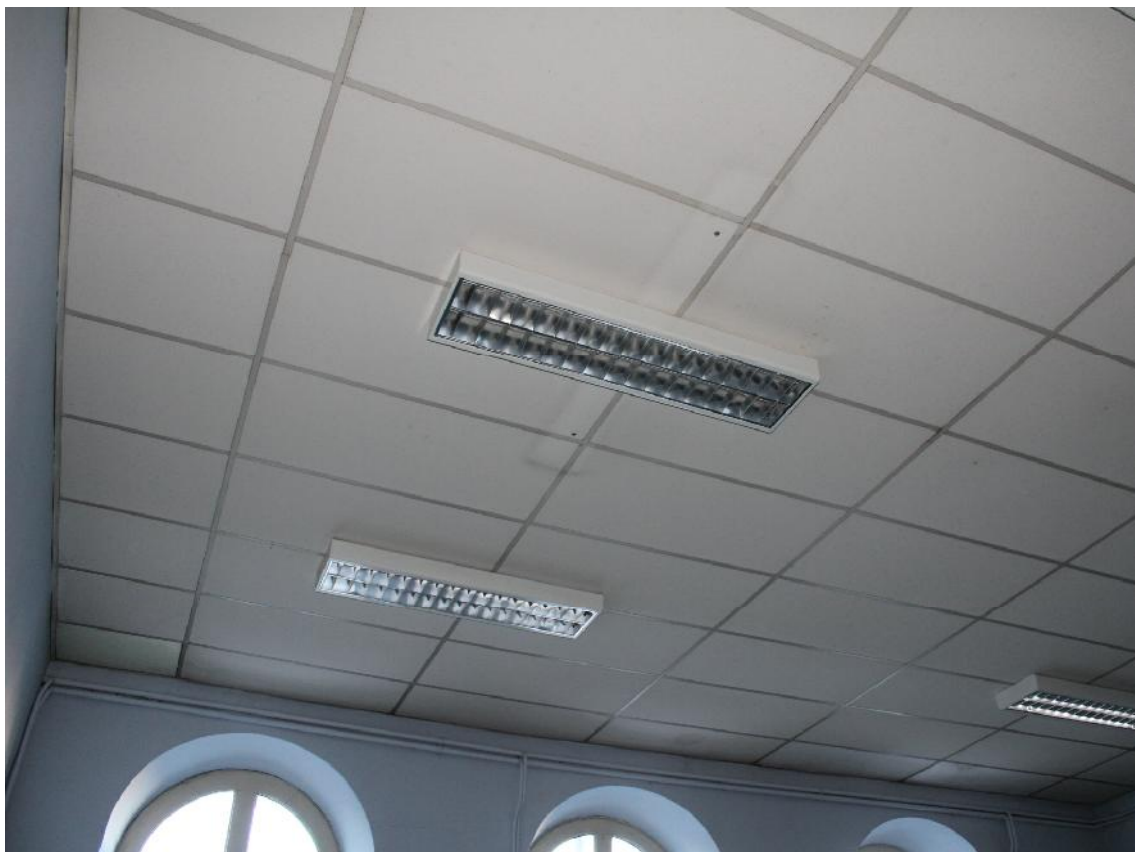
Foto 12_Particolare controsoffitto e corpi illuminanti
