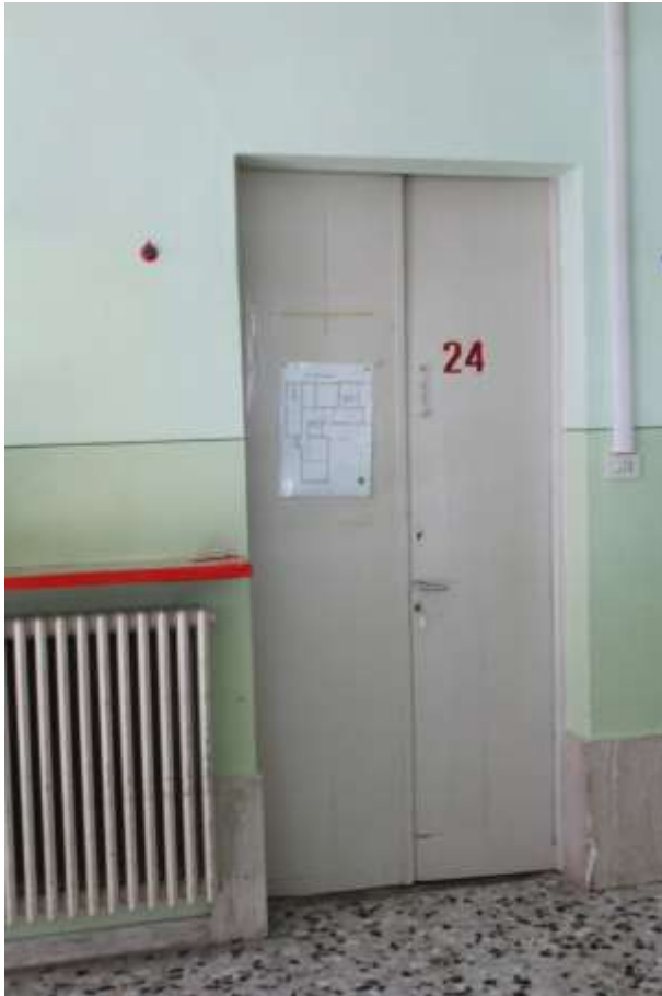
Porte interne aule, doppio battente, con un'anta fissa
