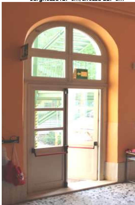
Prospetto sud - Tipologia serramento uscita di sicurezza Legno vetro doppio – telaio centinato Larghezza 157 cm/altezza 308+57 cm
