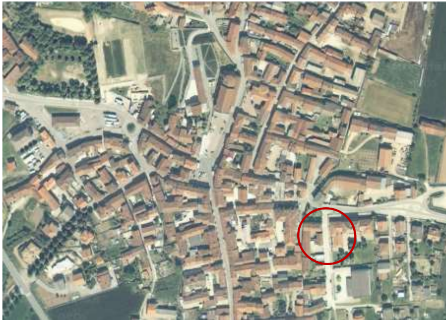
Foto 1: Immagine aerea, fabbricato oggetto d'intervento
