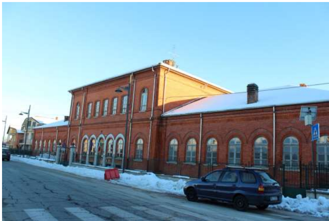
Foto 2: Immagine dell'edificio scolastico
