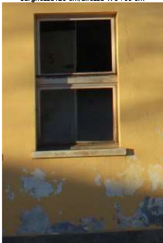
Prospetto sud - Tipologia serramento servizi igienici Legno vetro doppio – telaio semplice Larghezza 80 cm/altezza 130 cm
